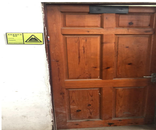
危险废物暂存间
